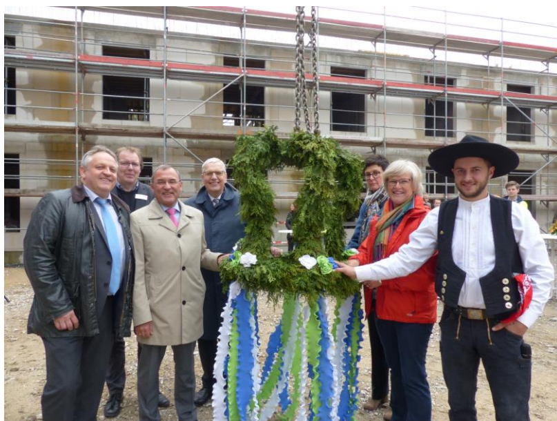
Foto: Richtkranz am neuen LVR-Haus 56.jpg
