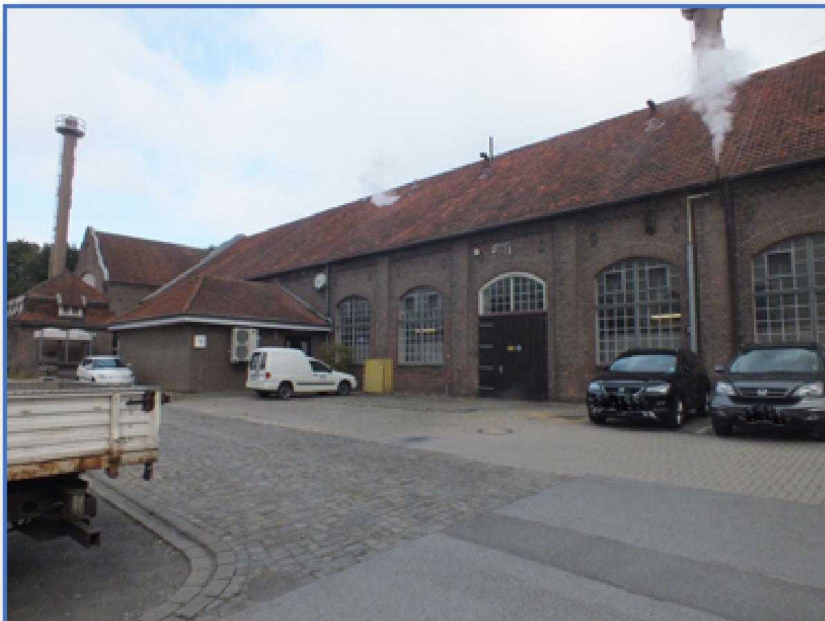
Kraftwerk in Bedburg-Hau
